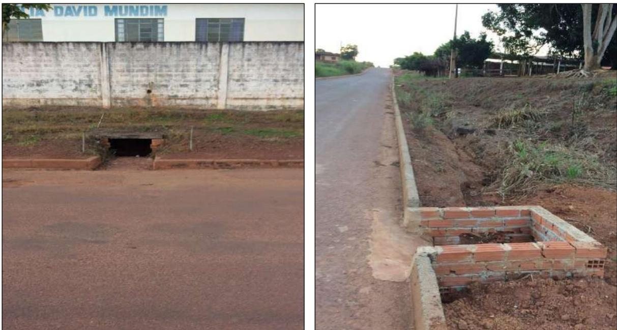
**Figura 114-** Dispositivos coletores de águas pluviais no município de Espigão do Oeste
