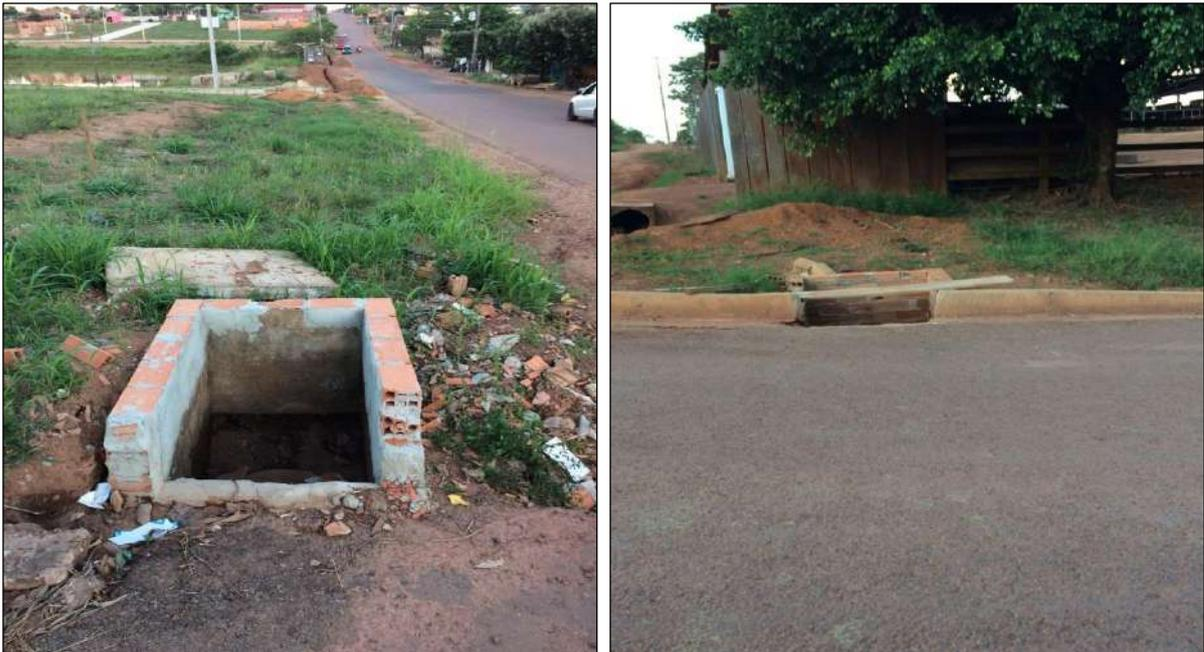
**Figura 113-** Boca de lobo mal dimensionada
