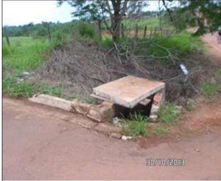
**Figura 74** - Boca de lobo em mau estado de conservação e acúmulo de lixo na vala de infiltração
