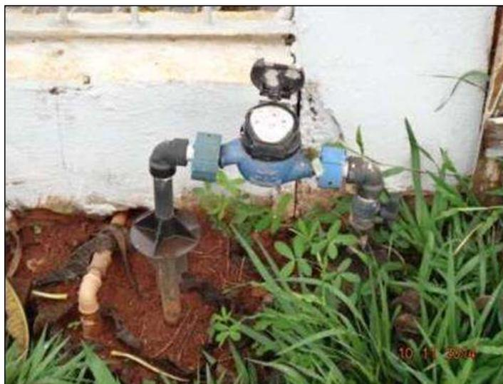
**Figura 46 - Hidrômetro instalado na residência**
