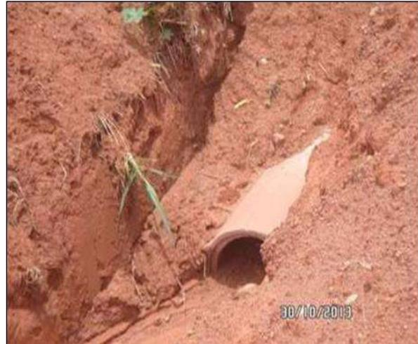
**Figura 80** - Área de ocorrência de erosão do solo na zona urbana de Espigão do Oeste
