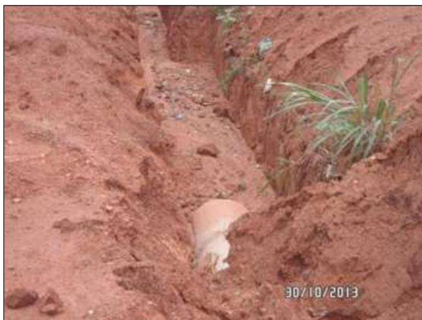
**Figura 78** - Obstrução do canal de microdrenagem inacabado
