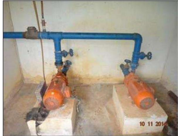
**Figura 24** - Conjunto motor-bomba
