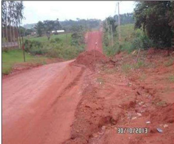
**Figura 79** - Ocorrência de erosão na margem da via pública de Espigão do Oeste
