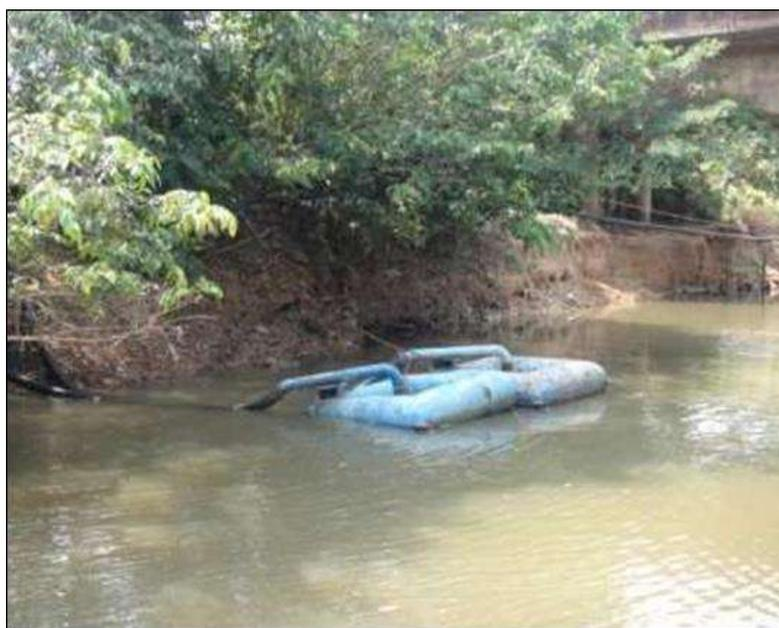
**Figura 21** - Sistema de captação de água na Sede Municipal
