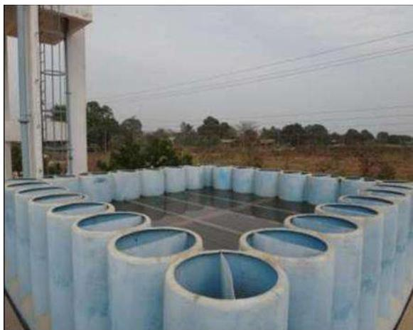
**Figura 36 -** Flocculação e decantação
