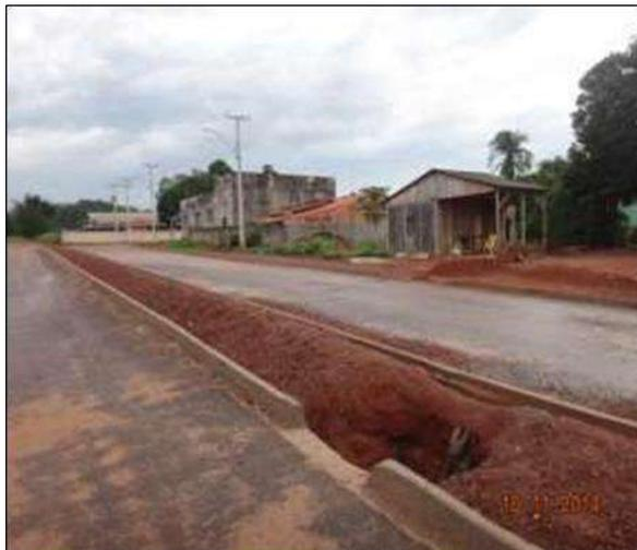
**Figura 75** - Meio-fio com presença de boca de lobo pra receber as águas pluviais
