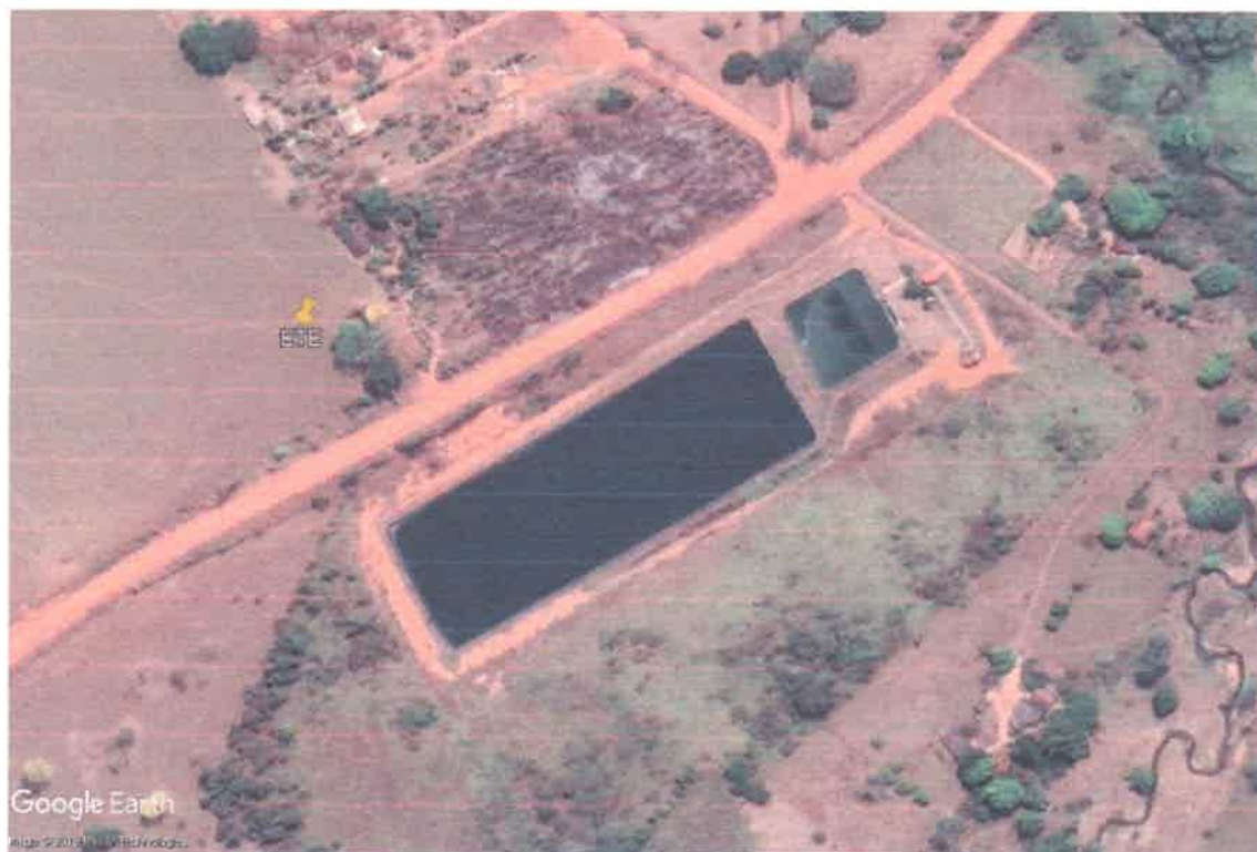
Figura 5.10: Vista da ETE na Sede de Espigão D'Oeste
