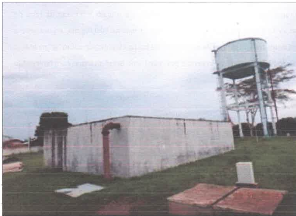
Figura 5.8: Reservatórios da Sede
